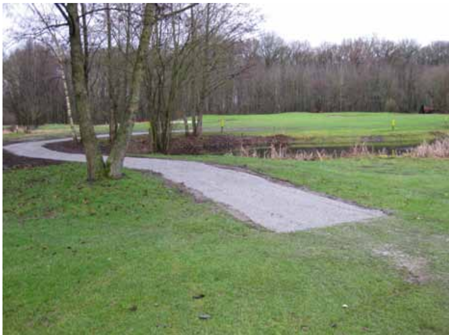
Die Bauarbeiten sind inzwischen abgeschlossen.
